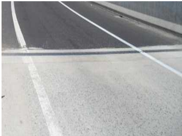
교면포장 접속도로 상태양호
