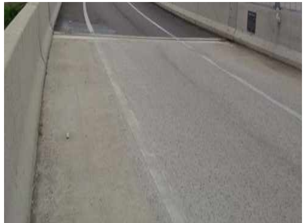
교면포장 접속도로 상태양호
